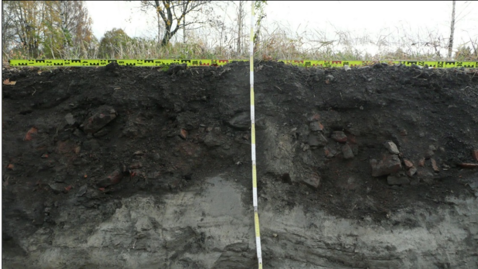
Sekoittunutta tiilimurskakerrosta rakenteen R12 leikkauksessa.
