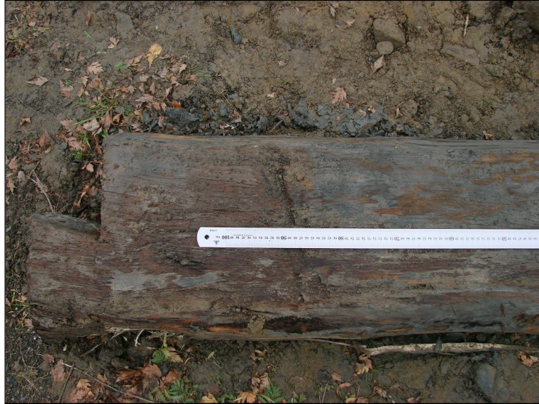
Rakenteen 17 arkkurakenteen salvokseksi lovettua lankkua.
