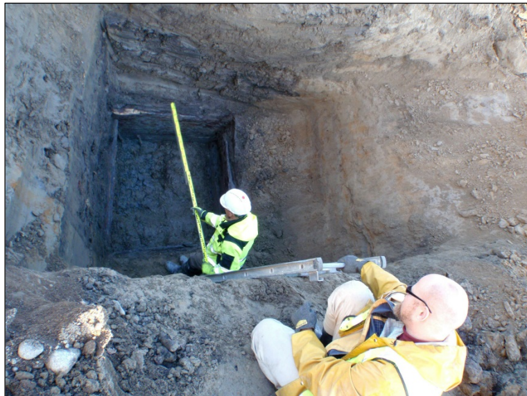
Rakenteen R17 hyvin säilynyttä arkkurakennetta dokumentoidaan.
